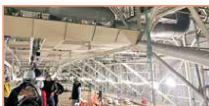
鳥取産業体育館アリーナ照明改修
